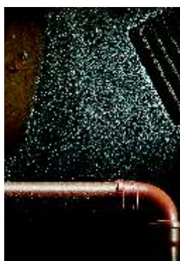
Esgotos e águas residuais
